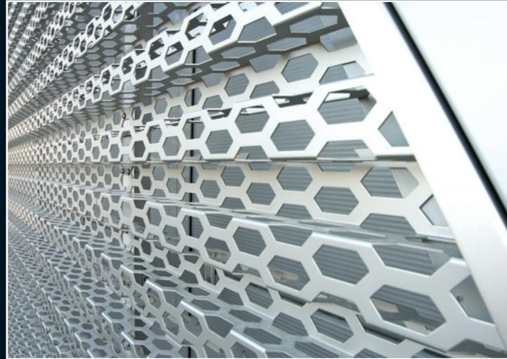
Die Aluminiumfassade ist perforiert (ca. 50 % offene Fläche), horizontal gekantet und hell Silber eloxiert (E6EV1). Mindestdicke 25 my, gemäß DIN 17611. Kantmaß der Standardpaneele ca. 2500 x 750 mm, mit einer Sechsecklochung 61,5 mm x 26 mm, die Lochung ist reihenweise versetzt.
