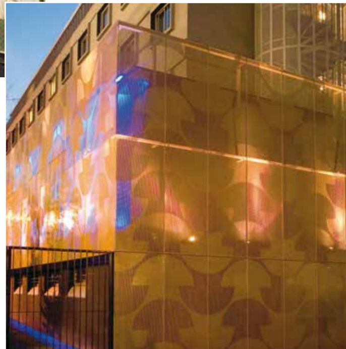
Diffuses Tageslicht im Raum und atemberaubende Lichteffekte bei Nacht – perforierte Bleche spielen in der Architektur der Maison du Portugal in Paris eine tragende Rolle. Geometrische Strukturen entstehen durch Stanzungen von Langlöchern in zwei unterschiedlichen Größen. Die 3 mm starken Aluminiumbleche werden durch eine vergoldete Oberfläche zusätzlich veredelt.
