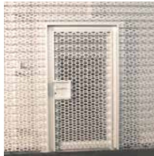
Lochbleche gewährleisten bei transparenter Anmutung einen guten Sichtschutz, der bei der Fassadengestaltung von gewerblich genutzten Gebäuden oft eine Rolle spielt.
